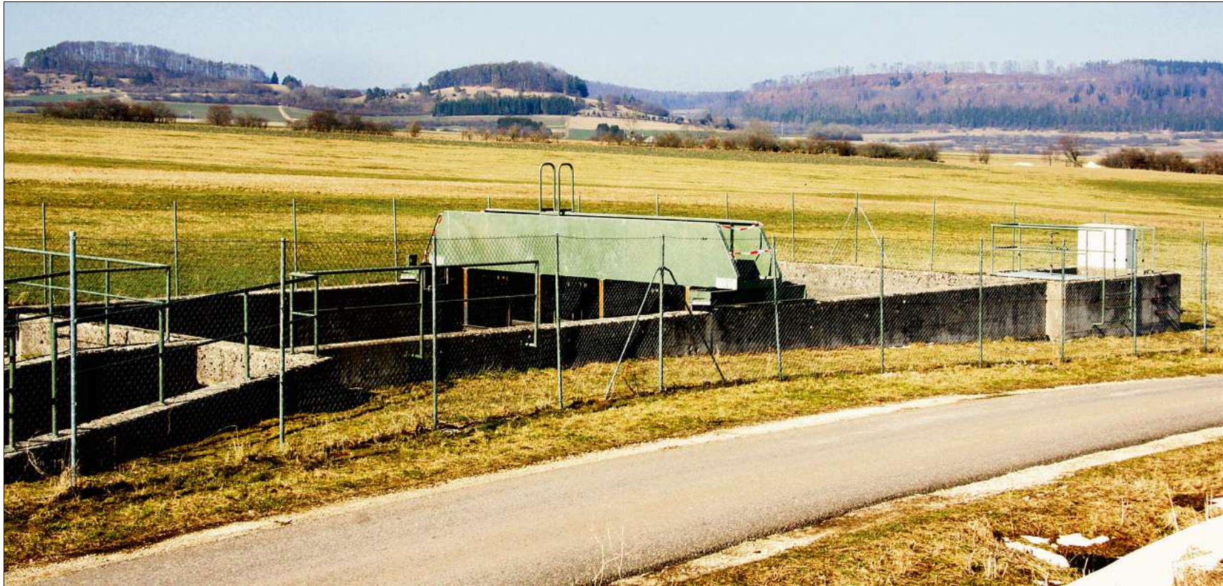
Ring frei für die nächste Runde in Sachen Ringinger Regenüberlaufbecken: In einigen Monaten wird es eine mündliche Verhandlung vor dem Verwaltungsgerichtshof in Mannheim geben. Foto: Rapphel-Kieser
